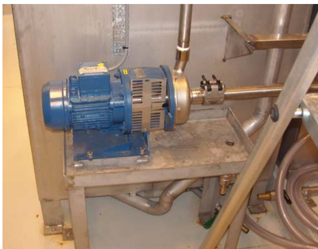
¾" Sentrifugalpumpe med vortex løpehjul
