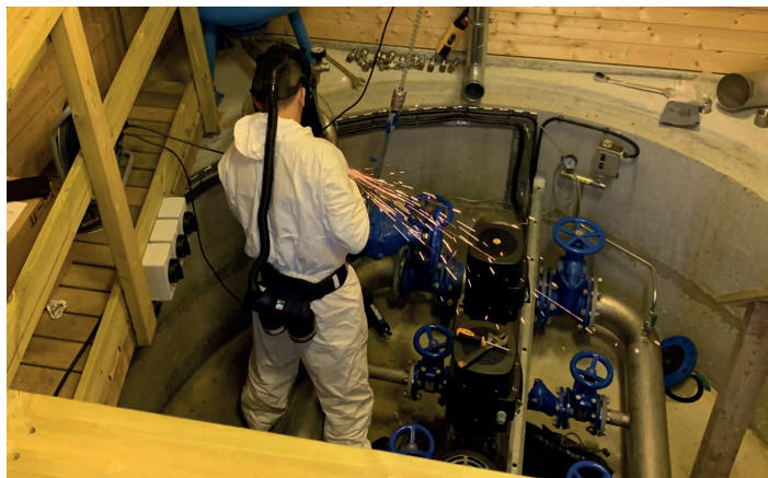
Kommunens rørleggere gjør tilpasninger på pumpestasjon
