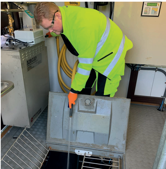
Patrick Fiskå spylar med slange tilkoblet brutt vannspeil
