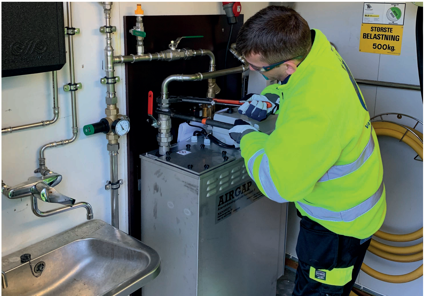
Stig Erik Løvaas monterer utstyr for brutt vannspeil
